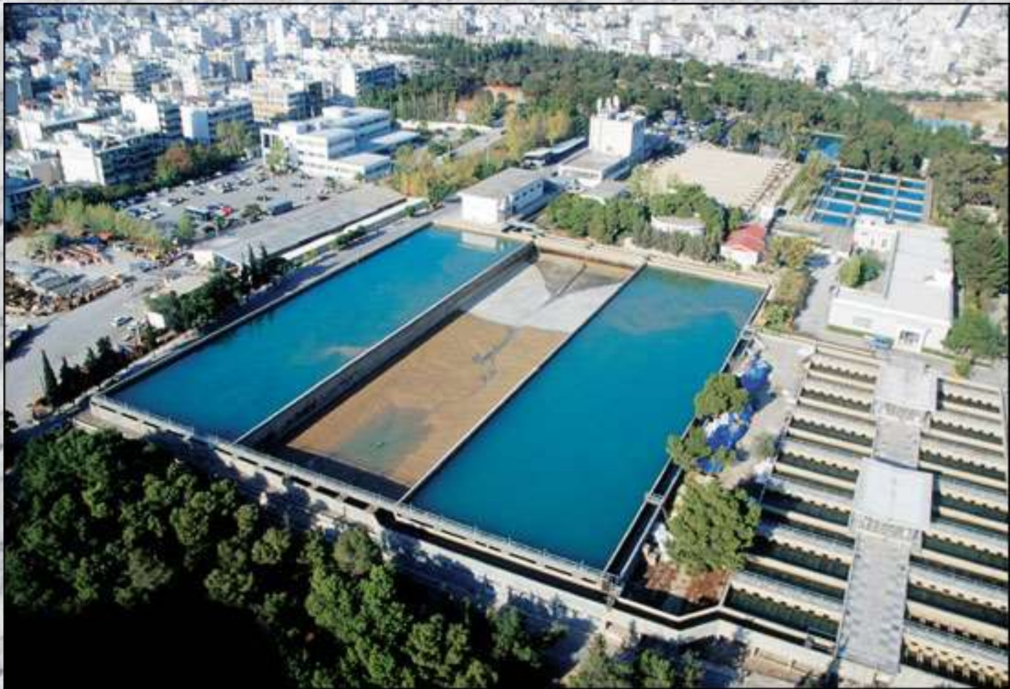
Μονάδα Επεξεργασίας Νερού Γαλατσίου
